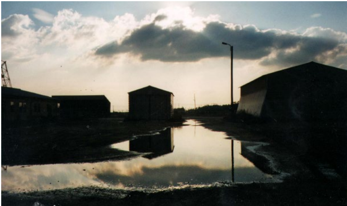
Abb. 3-3 Ehemalige Tagesanlagen an der F 60
