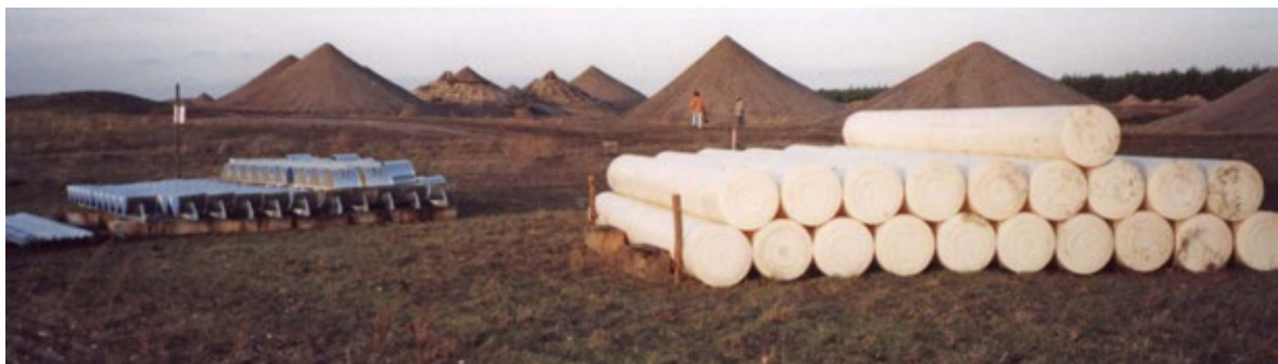
Abb.3-11 Baustelle Pegelturm, im Hintergrund Kunstlandschaft mit Mounds
